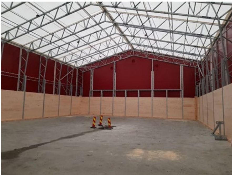
Figur 2 – Eksempel på ferdig hall innvendig
