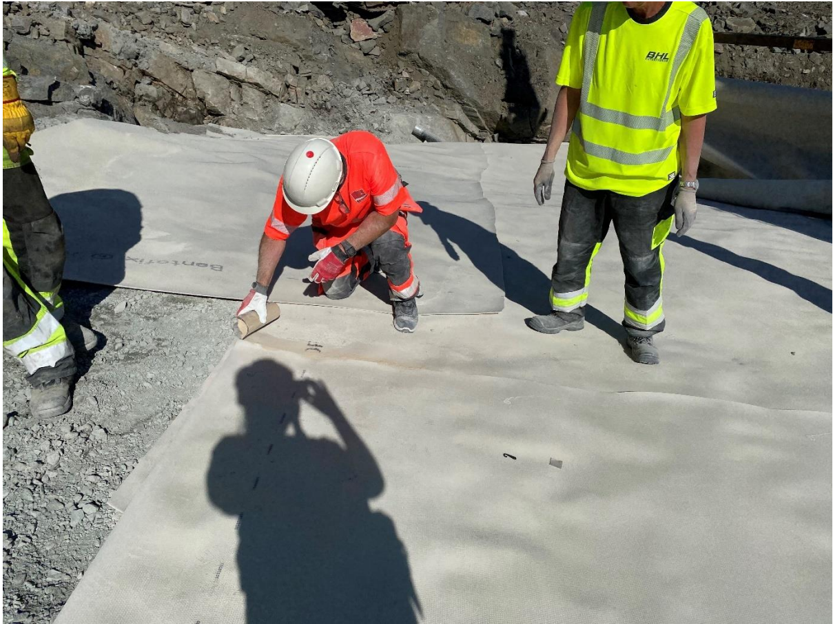
Figur 20: Arbeid med membranskjøter
