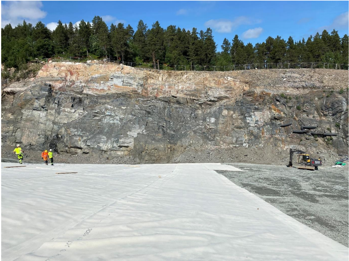
Figur 19: Utlekking av membran
