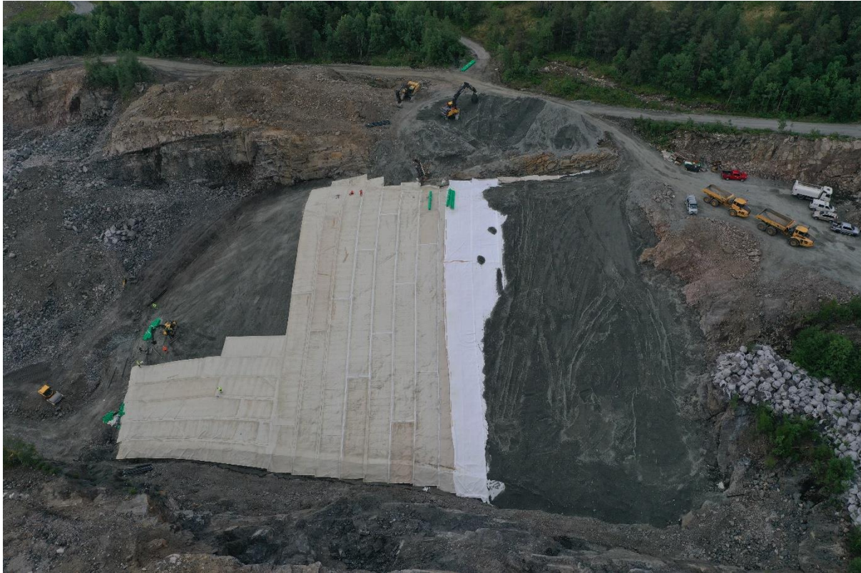
Figur 18: Utlekking av membran, fiberduk og dreneringslag
