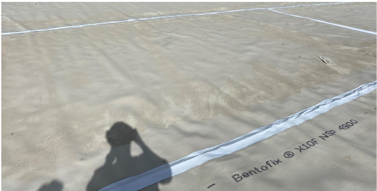
Figur 21: Ferdig lagt membran med teipet skjøter
