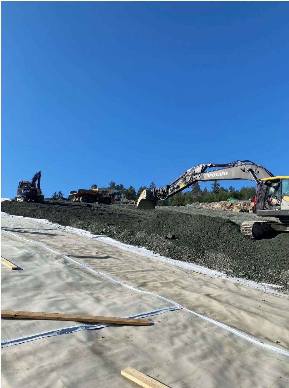
Figur 22: 40 cm dreneringslag over membran
