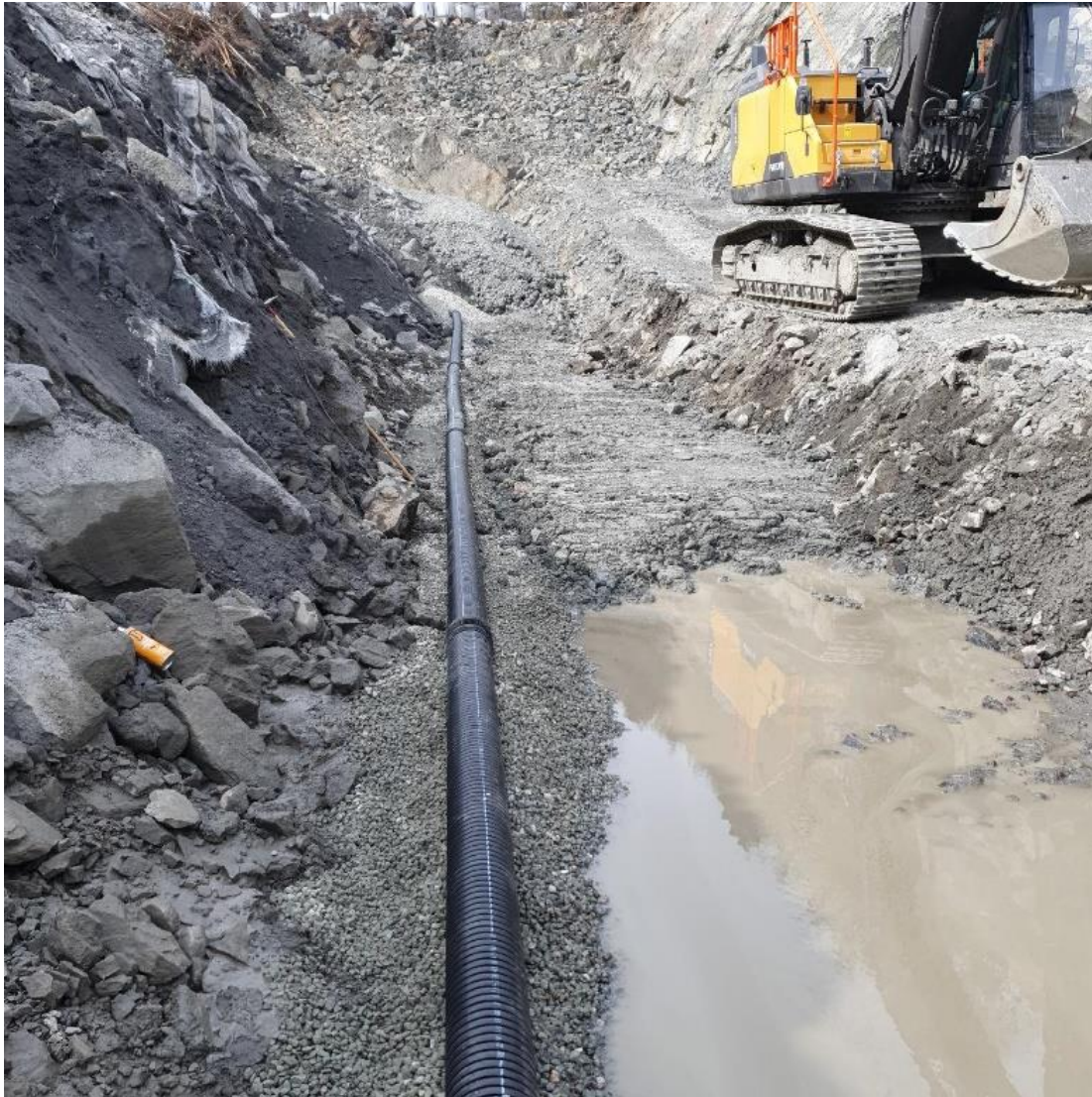
Figur 10: Fundament leirvoll og sigevannsystem
